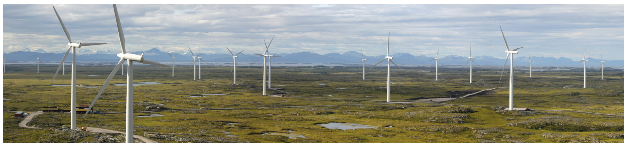
Ci-dessus, le parc éolien de Smøla, Møre og Romsdal, Norvège.
